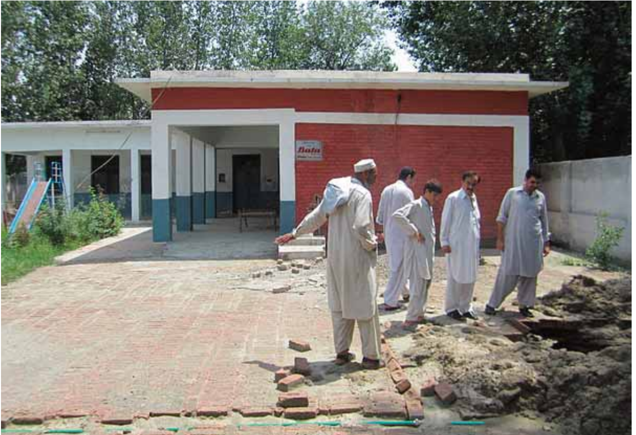
▣ Die zerstörte Wasserversorgung der Schule wird untersucht.
